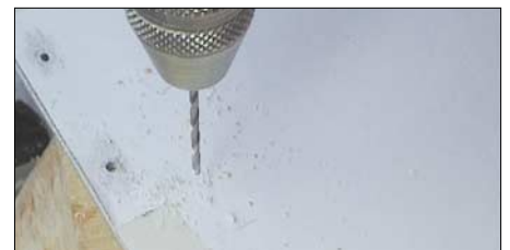
Bild 3: An den markierten Lochmittlepunkten werden durch das Papier hindurch Pilotbohrungen angebracht und danach auf den gewünschten Durchmesser erweitert.
