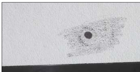
Bild 1: Beim Reiben mit einem Bleistift ergibt sich ein Abbild des Gewindelochs auf dem Papier. Ein Durchstechen ist zu vermeiden, da dies das Zielen beim Bohren erschwert.
